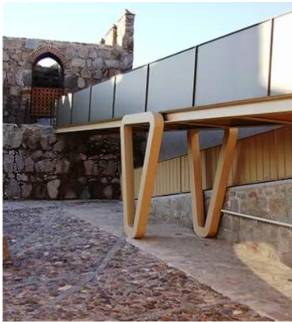
Rampa junto a la muralla de Ávila
