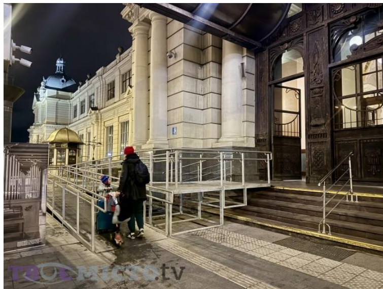
Рис. 2.47 — Пандус на головному вході залізничного вокзалу у Львові — приклад тимчасової/модульної конструкції, що робить історичну будівлю доступнішою без суттєвого втручання у сам фасад (Твоє місто, 2025)
