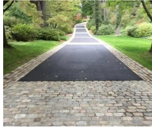
Рис. 2.8 — Частина покриття перекрита сучасним шаром (асфальт) для створення гладких маршрутів (Stone Curators, 2025)
