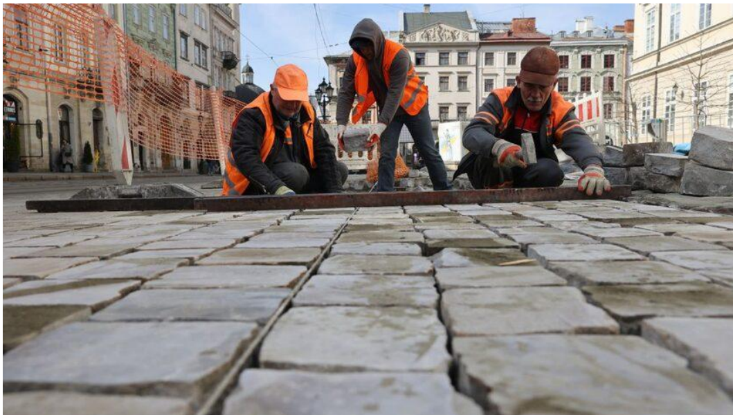
Рис. 2.51 — Львів перейняв від кількох європейських міст цікаве рішення для облаштування доступності брукованих вулиць і площ — доріжки доступності. Бруківку демонтують і шліфують до гладкого рівня без вигину. Товщина бруківки залишається тією самою, в середньому 17 сантиметрів, але її поверхня стає рівною: так людям на колісних кріслах і дитячим візкам зручніше проїхати (Lviv City Council, 2025).
