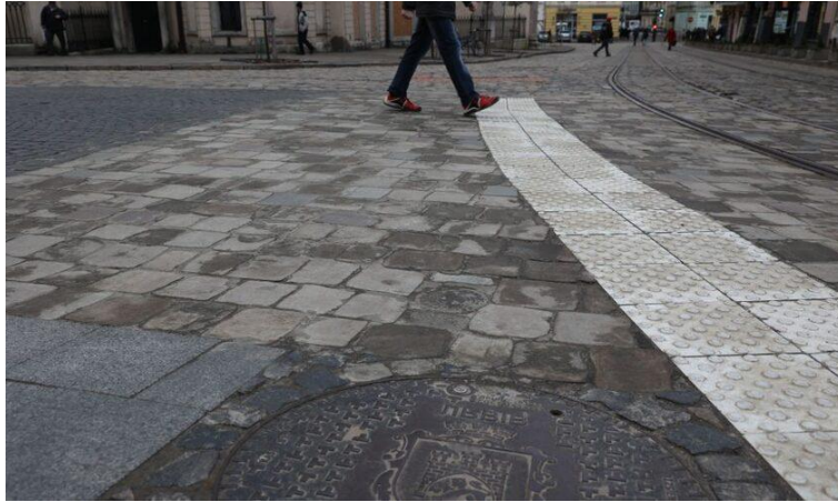
Рис. 2.48 — Покращене тротуарне покриття та встановлені тактильні смуги на площі Ринок у Львові (Роман Балук)
