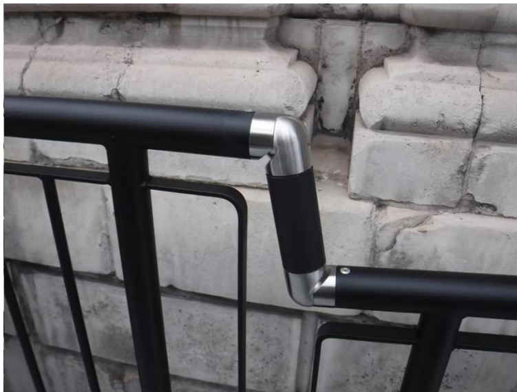
Рис. 2.23 — Поручні, що виконані з матеріалу, комфортного для використання в холодну пору (Rapid Ramp, 2019)
