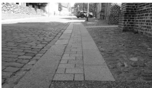
Figura 57. Viborg. Dettaglio della pavimentazione di una strada storica, dove è stata progettata una corsia con caratteristiche che consentono un uso confortevole e sicuro degli spazi per tutti (Fonte: https://realdania.dk/projekter/tilgaengelighed-historiske-bykerner )
