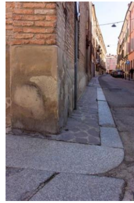
Figura 46-47. Città di Mantova. I marciapiedi, per tutta la loro lunghezza o in punti specifici come i passi carrabili, presentano pendenze trasversali eccessive. Ciò crea un rischio per le persone che utilizzano ausili per la mobilità, rendendo loro difficile muoversi in modo sicuro e confortevole (Sebastiano Marconcini, 2025).
