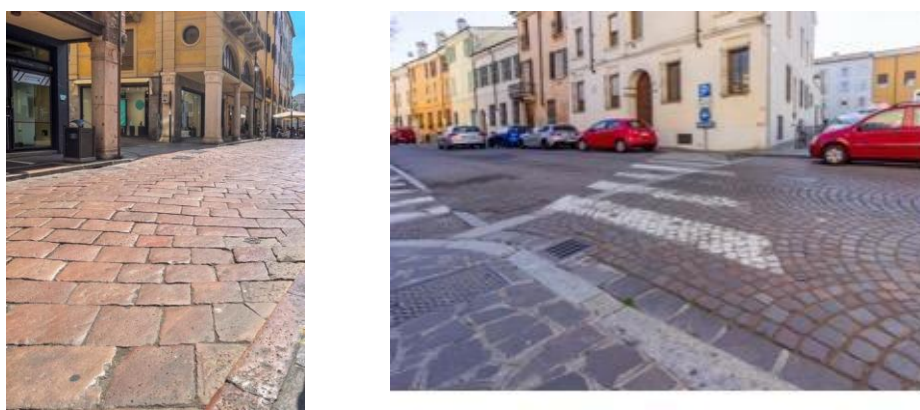
Figura 50-51. Città di Mantova. Nell'immagine a sinistra, una strada nella zona pedonale del centro storico; la pavimentazione è in scarse condizioni di manutenzione, con numerosi avvallamenti e discontinuità, che comportano un rischio di caduta. A destra, un attraversamento pedonale che si estende in diagonale, privo di pavimentazione tattile per l'orientamento, che rende difficile per i pedoni ciechi e ipovedenti identificarlo e attraversarlo in sicurezza (Sebastiano Marconcini, 2025).
