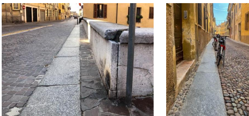
Figura 44-45. Città di Mantova. Marciapiedi stretti che non consentono il passaggio della sedia a rotelle e solo di un pedone alla volta, limitando così la mobilità delle persone con disabilità motorie e compromettendo la sicurezza e il comfort di tutti gli utenti (Sebastiano Marconcini, 2024).
