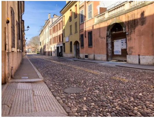
Figura 46-47. Città di Mantova. I marciapiedi, per tutta la loro lunghezza o in punti specifici come i passi carrabili, presentano pendenze trasversali eccessive. Ciò crea un rischio per le persone che utilizzano ausili per la mobilità, rendendo loro difficile muoversi in modo sicuro e confortevole (Sebastiano Marconcini, 2025).
